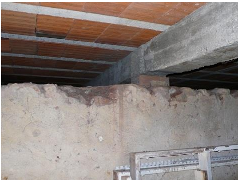
Slika 16: AB greda opterećena stropnom konstrukcijom [2]
