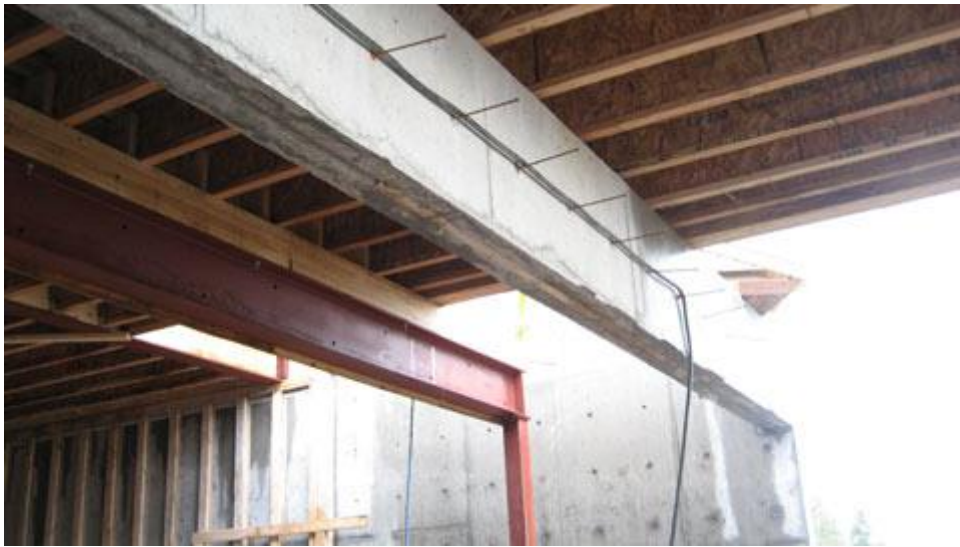
Slika 18: Drvene grede prenose opterećenje na AB gredu [4]
