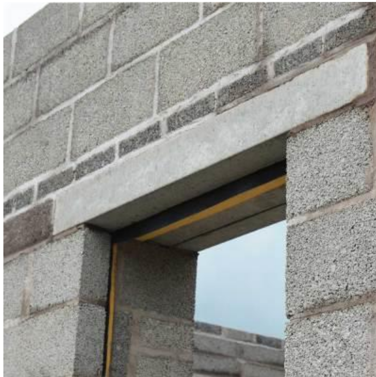
Slika 20: Betonski nadvoj u zidanoj konstrukciji [6]
