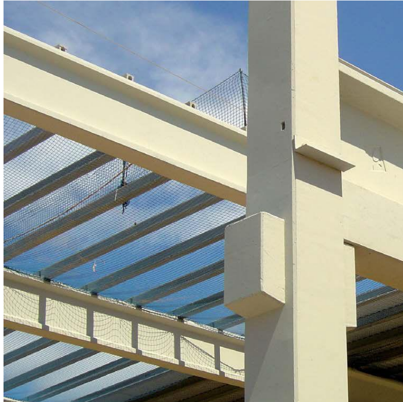
Slika 19: AB greda preuzima koncentrirana opterećenja čeličnih greda [5]
